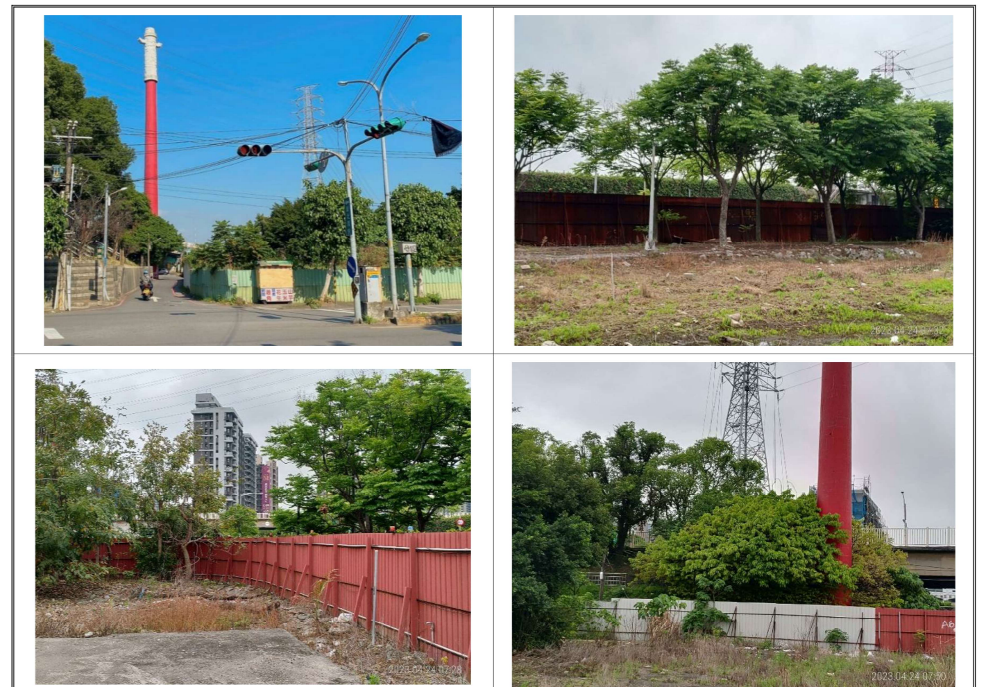
圖5-2 違章建築戶拆除清空現況(2023年攝)(變更後)
